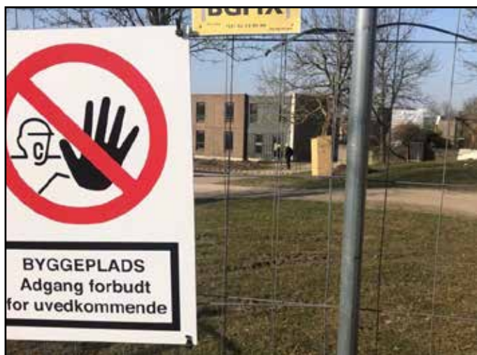
Den store byggesag i Galgebakken er pilotprojekt for, hvordan BO-VEST skal arbejde med lærlingeplaner og lave aftaler med entreprenørerne om, hvor mange lærlinge der skal indgå i hver byggesag, herunder hvordan der skal føles op på aftalerne.
